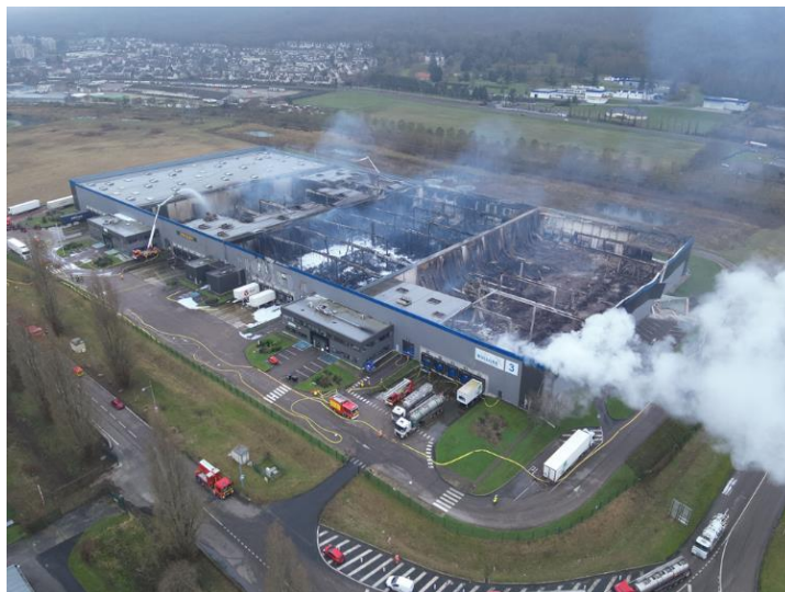
Figure 1: Image des cellules de l'entrepôt incendié (source : SDIS 76).
