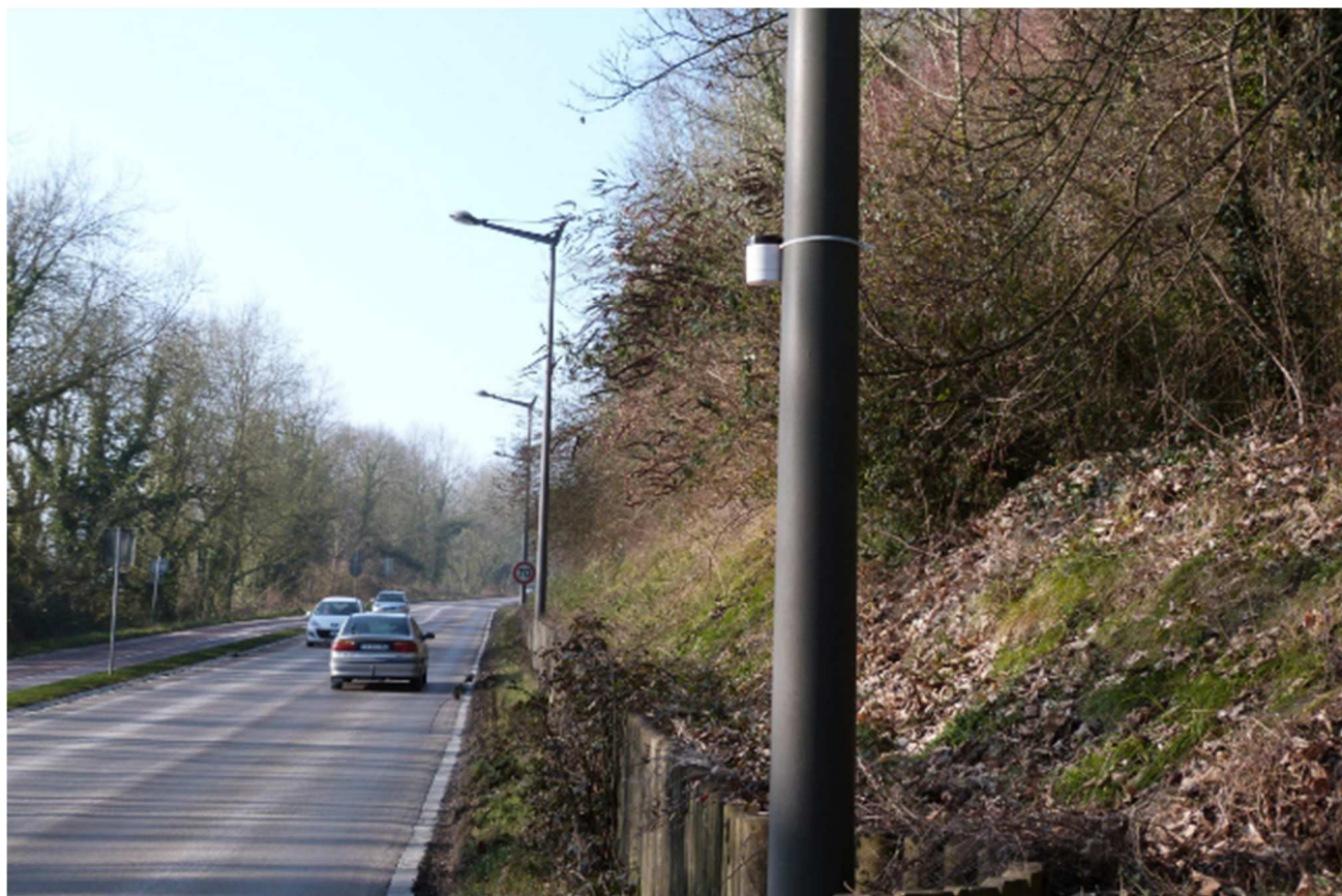
Figure 2 : Installation du matériel sur le terrain.
