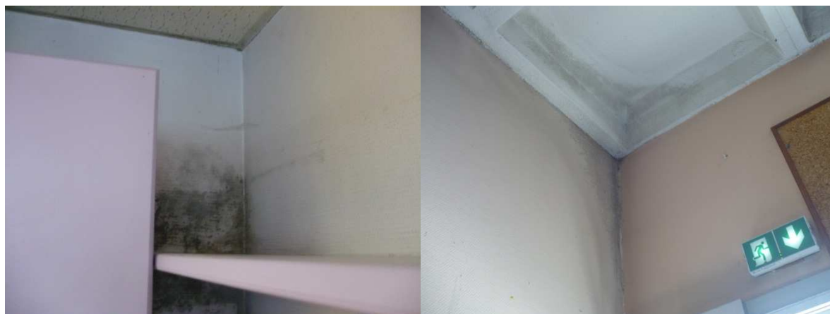
Figure 9 : site de prélèvements de surface (à gauche : classe 3 et à droite : classe 6)
