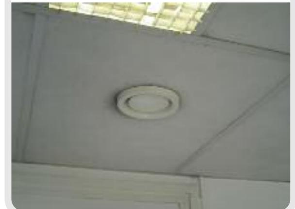
Photo 11 : Bouches d'extraction dans des sanitaires
