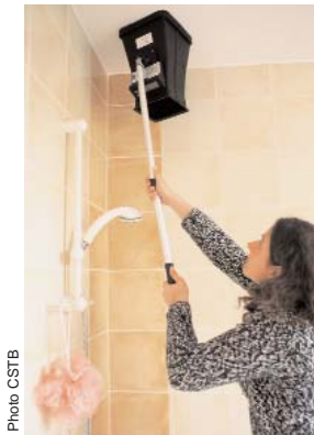
Mesure du débit d'air extrait sur une bouche d'extraction.
