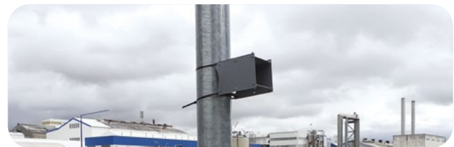
Abri boîte contenant le dispositif de mesure des COV.
